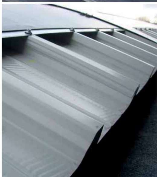
Detaliul acoperisului cu sistem fotovoltaic amorf.
